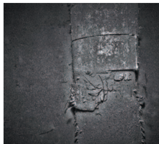
Abb. 14: Die Pipeline-Aufnahme mit der HUGIN-Kamera auf MV »Icebeam« zeigt eine Beschädigung der Ummantelung
